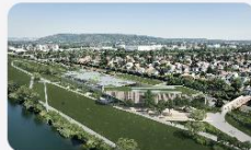
Station Strebersdorf – Seilbahn Kahlenberg
